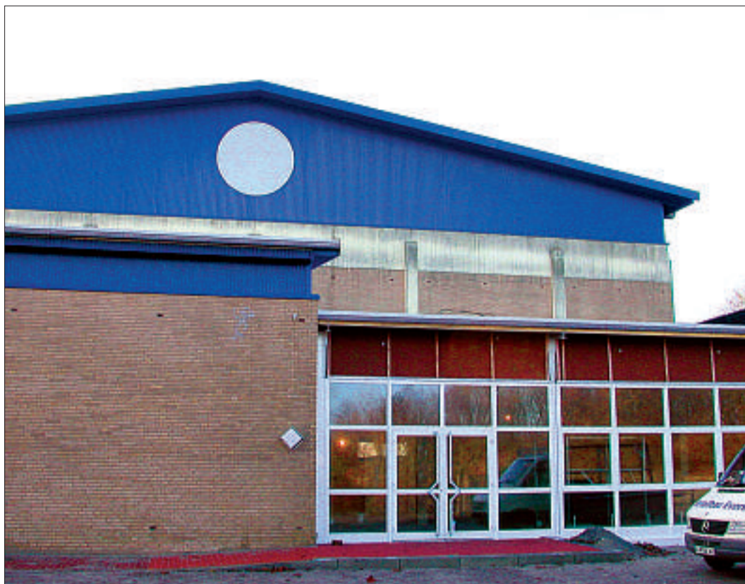
Im Foyer der Wildbahn-Turnhalle wird zwar noch kräftig gearbeitet, bis zum Hallenfußball-Turnier am 29./30. Dezember soll es aber benutzbar sein.
