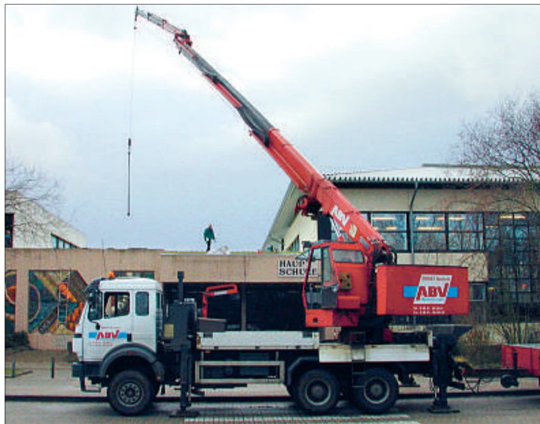
Das Flachdach der Hauptschule ist durch ein Wetterschutzdach ersetzt worden (rechts). Auch der Eingangsbereich wird neu überdacht.
