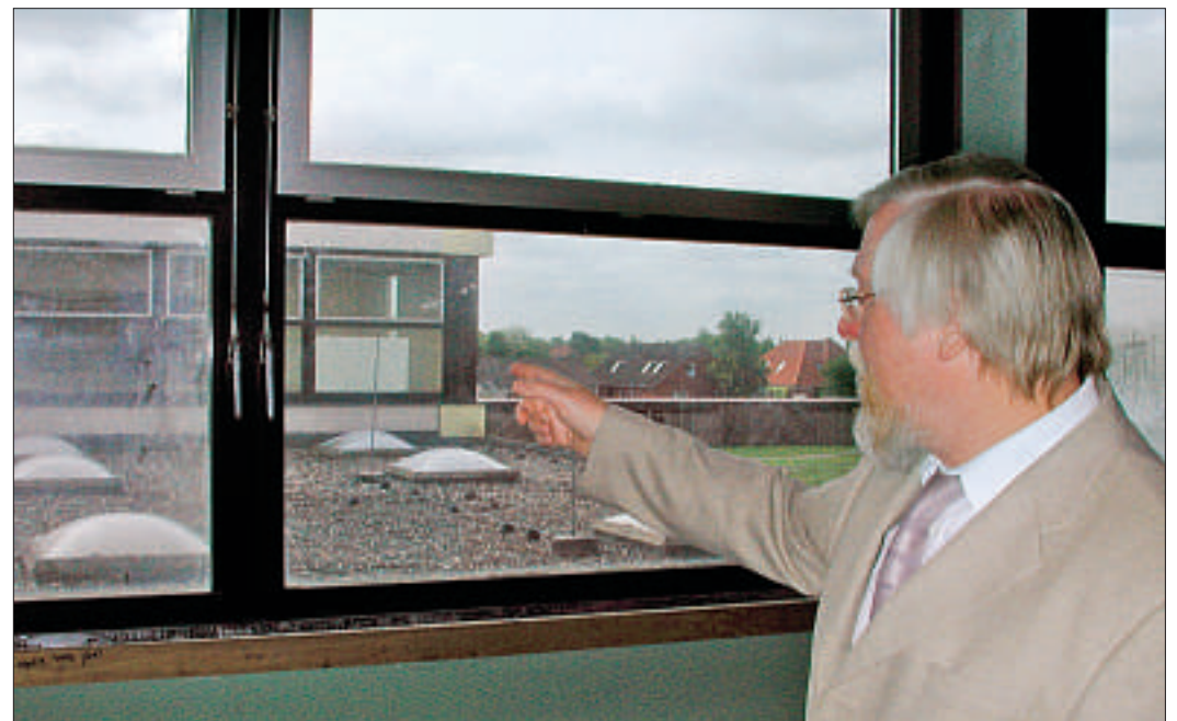
Lenhard Janssen zeigt auf den Dachbereich, der zum neuen Verbindungstrakt zwischen Hauptschule und der früheren Orientierungsstufe ausgebaut werden sollte. Dafür fehlt jetzt das Geld. Das Flachdach wird nur überdacht.
